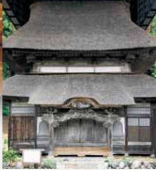
左写真は開山堂：屋根は茅葺き二重層、上部は入母屋造り、正面は唐破風向拝を有し、雲蝶の彫刻が施されています。
